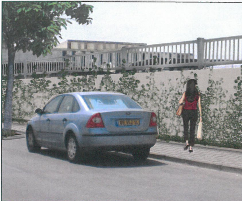
דוגמא להשלמה של סורג מעל קיר בנוי בגובה של כ 2 מטרים. (באזור התעשייה הקיר הבנוי יהיה בחיפוי אבן מתועשת וקופינג או טיח איכותי וקופינג).
